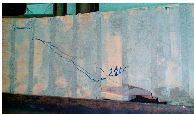
Рисунок 9 – Разрушение армокирпичной перемычки
